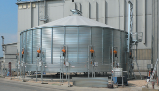
Silos in fase di montaggio. Silos being assembled and erected.
